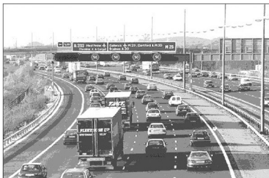
شکل ۲-۶- آزادراه تحت کنترل
